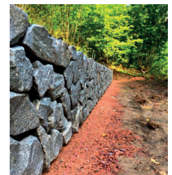
Lohkare-Steinmauer
