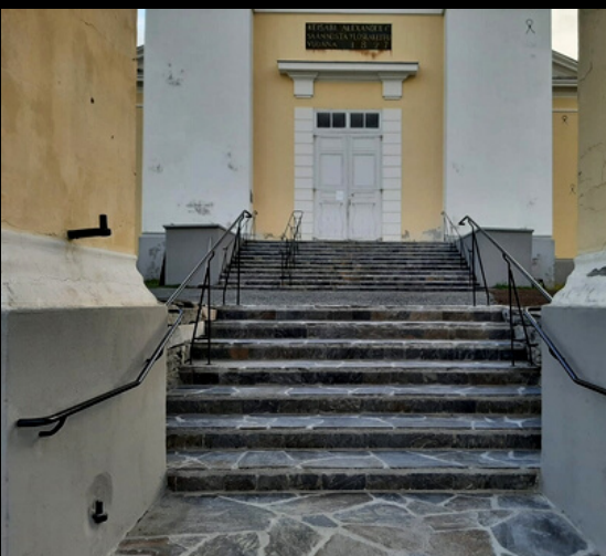
Die Treppen der Neuen Kirche von Keminmaa wurden unter Aufsicht des finnischen Zentralamts für Museen mit Stonelement-Steintreppen erneuert
