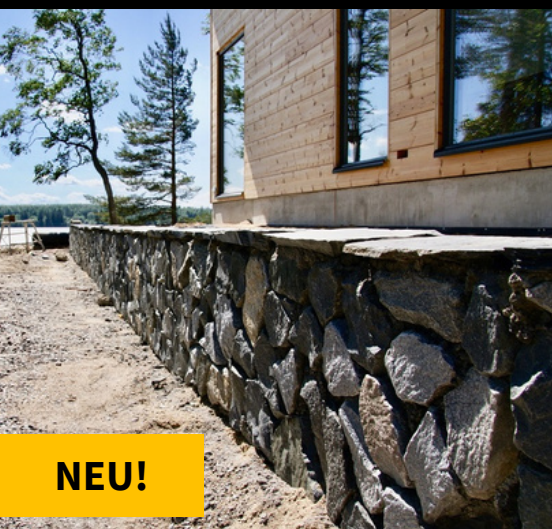
LOHKARE ist ein Steinelement, verkleidet mit einem finnischen Bruchstein
