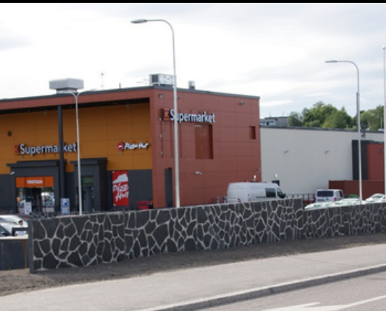
SLATE ist ein Steinelement, verkleidet mit einem Naturstein mit naturförmiger Kante
