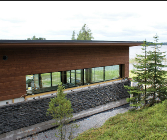
Die Stonelement-Wandelemente werden gewöhnlicherweise auf einem Fundament montiert
