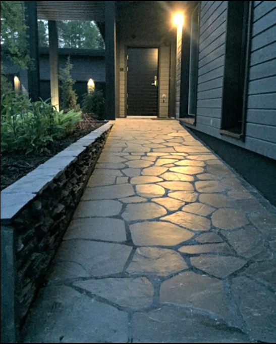
Mit Schieferstein verkleidete Rollstuhlrampe
