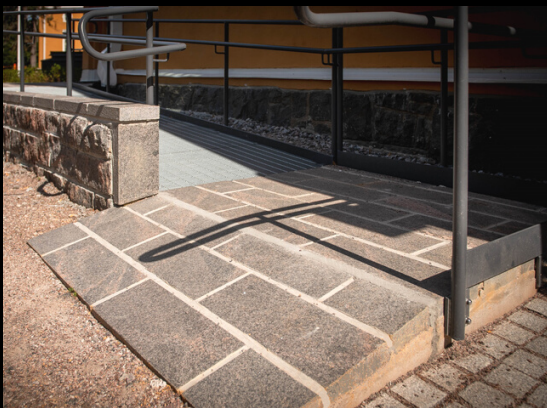
Mit finnischem Granit verkleidete Rampe und Stützmauer
