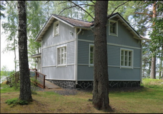
Fundament bestehend aus mit Schieferstein verkleideten Steinelementen
