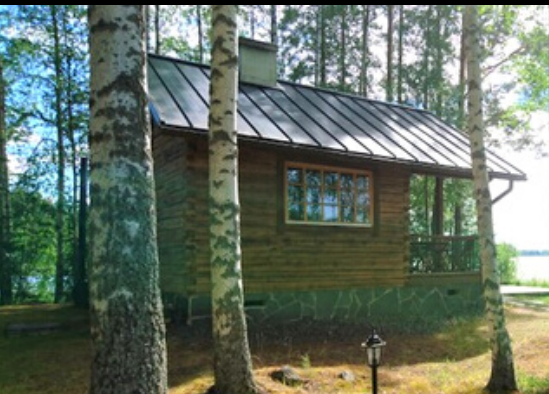
Fundament fürs Blockhaus aus Natursteinelementen
