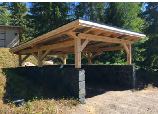
Beidseitig mit Naturstein verkleideter Sockel eines Carports
