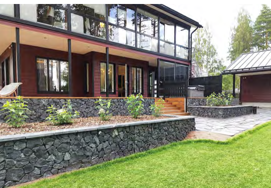
Eine mit L-Steinen errichtete Terrasse
