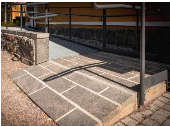
Mit finnischem Granit verkleidete Rampe und Stützmauer
